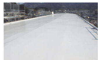
屋上防水改修
