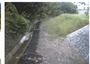
環境に配慮した護岸
