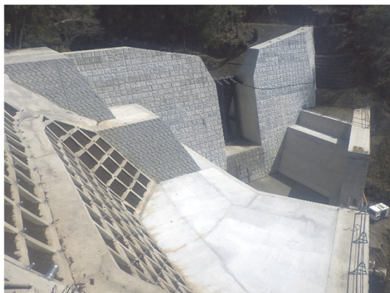
北川（京都市西京区）砂防えん堤
