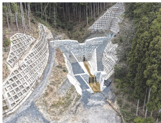
中ノ谷川（宇治田原町）砂防えん堤
