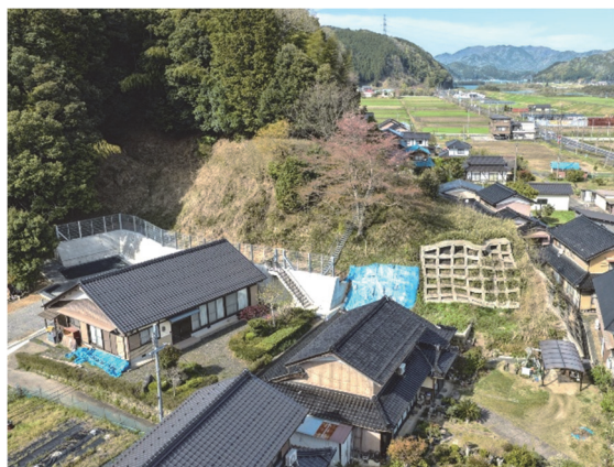
志高（舞鶴市） 擁壁工
