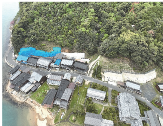
小坪（伊根町） 擁壁工
