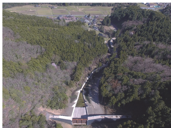
篠原西一谷川（京丹波町）砂防えん堤
