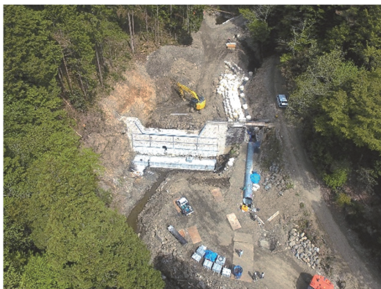
津の本谷川（南丹市） 砂防えん堤修繕
