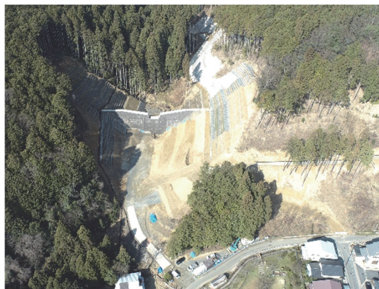
蛙ヶ谷川（京都市北区）砂防えん堤
