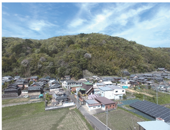
大野（木津川市） 法枠工
