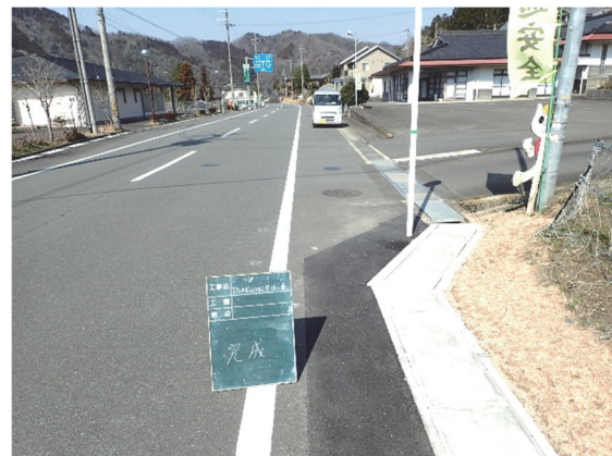
完成（側溝蓋の設置）
