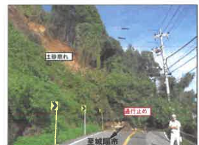
【被災の様子 平成25年9月】
