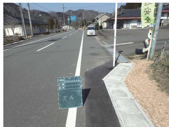
完成（側溝蓋の設置）
