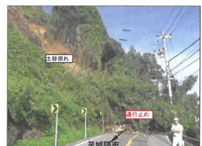
【被災の様子 平成25年9月】
