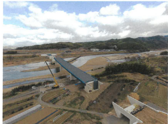
施工の状況（木津川渡河橋りょう部）
