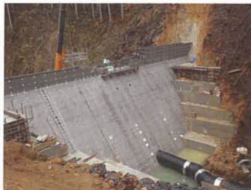
堰堤施工状況（令和2年3月）
