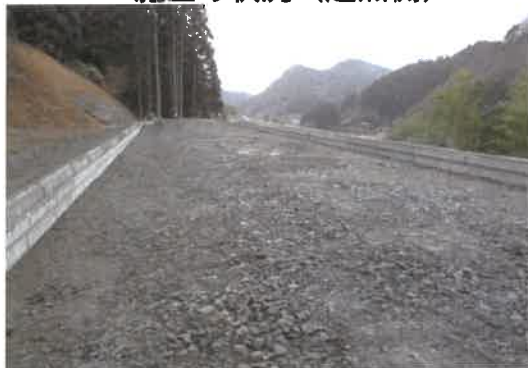
施工の状況（起点側）
