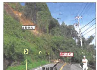
【被災の様子 平成25年9月】
