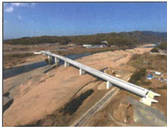
施工の状況（木津川渡河橋梁部）
