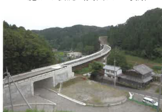
施工の状況（奥山田2号橋）
