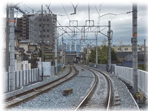
JR奈良線の高速化・複線化第二期工事 (新田～城陽間)
