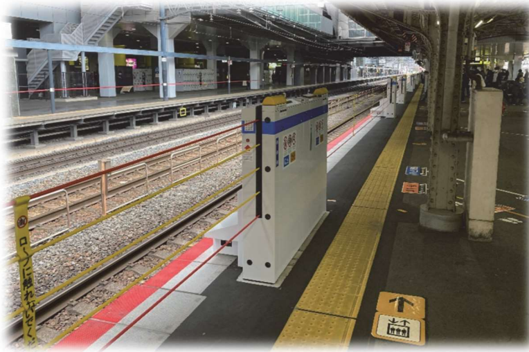
鉄道駅舎バリアフリー化設備整備事業 (JR京都駅ホーム柵整備)
