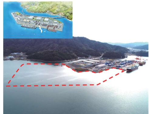
舞鶴国際ふ頭Ⅱ期整備
