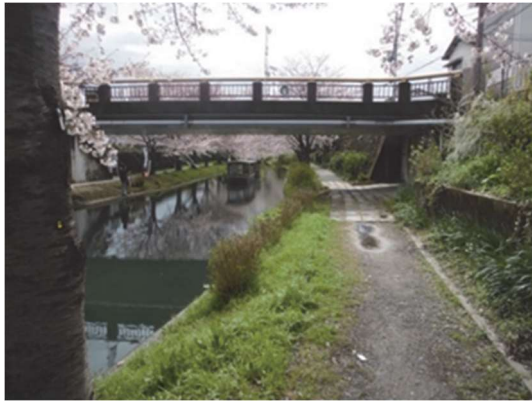
伏見港の園路再整備
