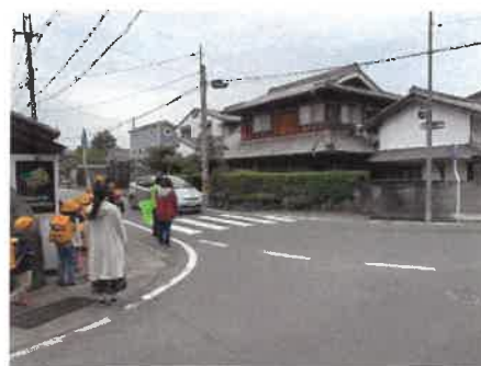
一般府道東掛小林線（亀岡市曾我部町） 対策内容：交差点改良 1箇所
