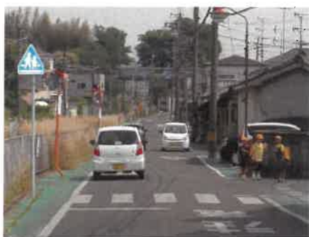
主要地方道上粕城陽線（井手町井手） 対策内容：歩道設置 300m
