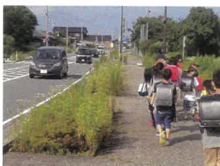
国道178号（宮津市江尻） 対策内容：防護柵設置 50m
