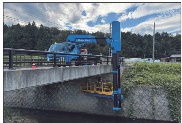
定期点検（橋梁点検）
