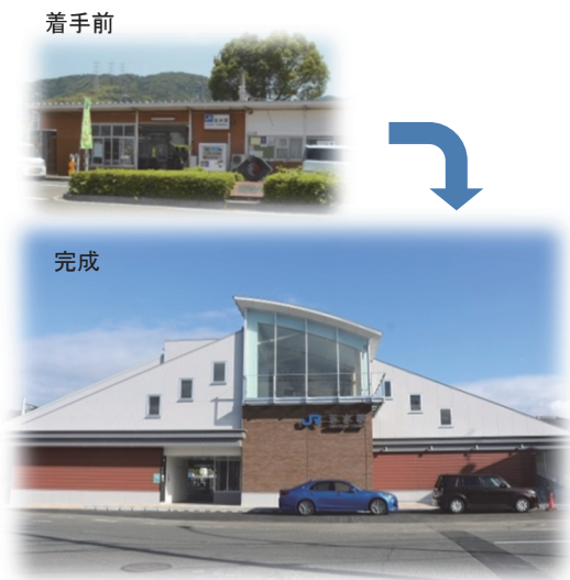
JR奈良線玉水駅橋上化 （平成30年度開業）
