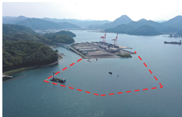
舞鶴国際ふ頭Ⅱ期整備
