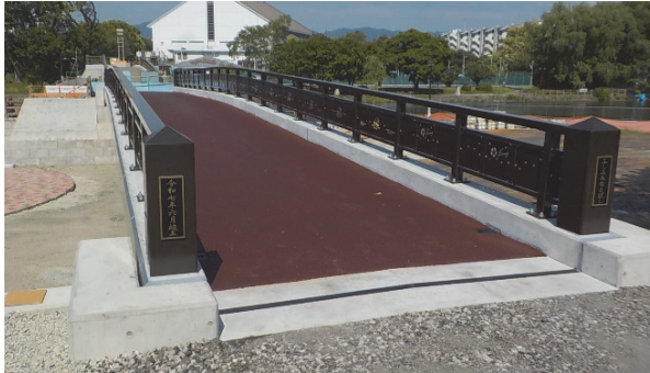
伏見みなと橋（延伸完了）
