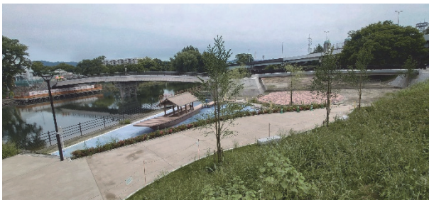
伏見みなと公園広場（完成部分）
