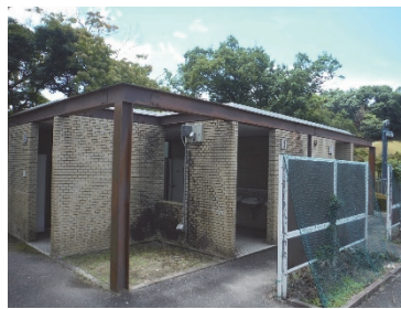
山城総合運動公園 屋外トイレ
