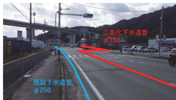
二条管増設箇所
