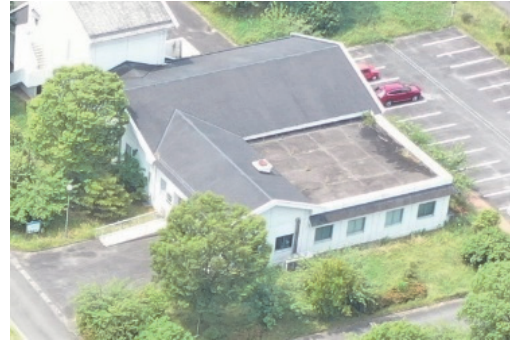
第1ポンプ棟(耐震補強)
