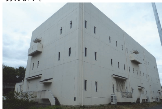
水処理電気棟（耐震補強）
