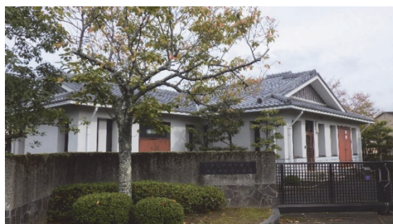
中継ポンプ場（耐震補強）
