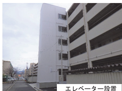
エレベーター設置
