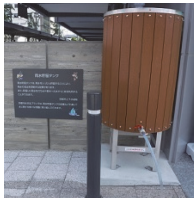
設置例 2 （京都市上下水道局）
