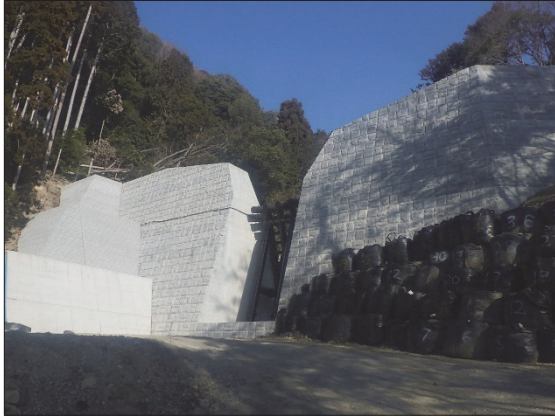
北川（京都市西京区）砂防えん堤
