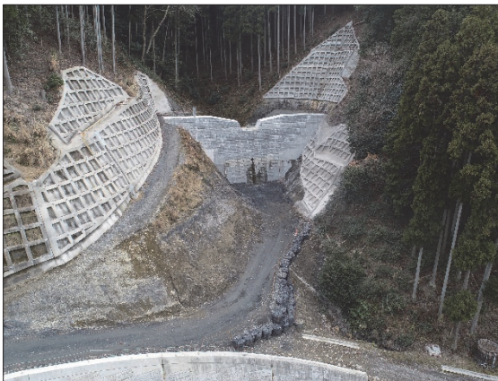
中ノ谷川（宇治田原町）砂防えん堤
