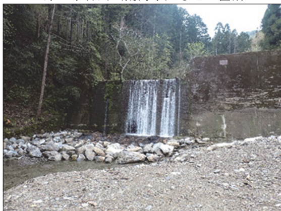
津の本谷川（南丹市） 砂防えん堤修繕
