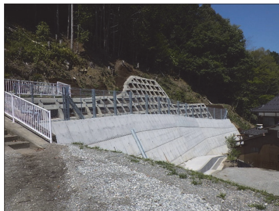
志高（舞鶴市） 擁壁工
