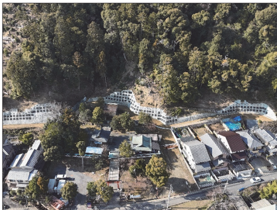
松室（京都市西京区） 土砂防護柵
