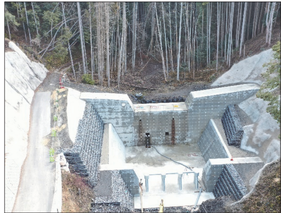
門前川（和東町）砂防えん堤
