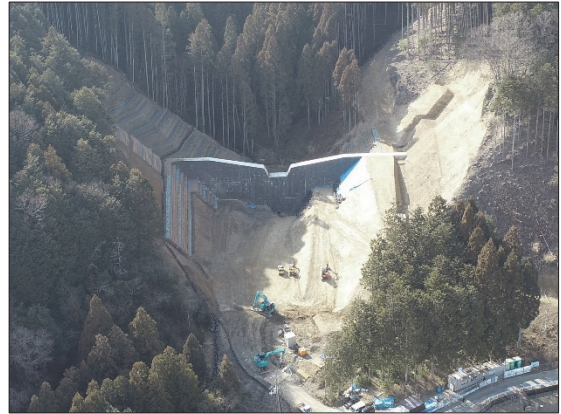
蛙ヶ谷川（京都市北区）砂防えん堤
