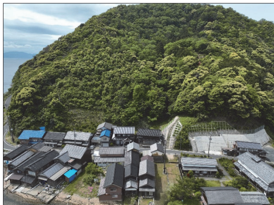
小坪（伊根町） 擁壁工
