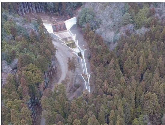
篠原西一谷川（京丹波町）砂防えん堤
