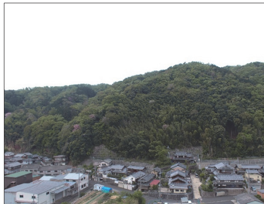
大野（木津川市） 法枠工
