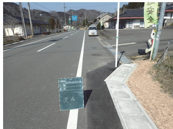
完成（側溝蓋の設置）
