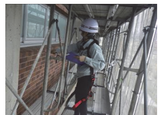
(5) 工事監理(外壁補修検査)
