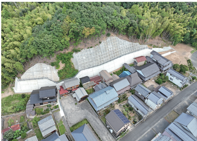
○小田宿野 急傾斜地崩壊対策事業（宮津市）
