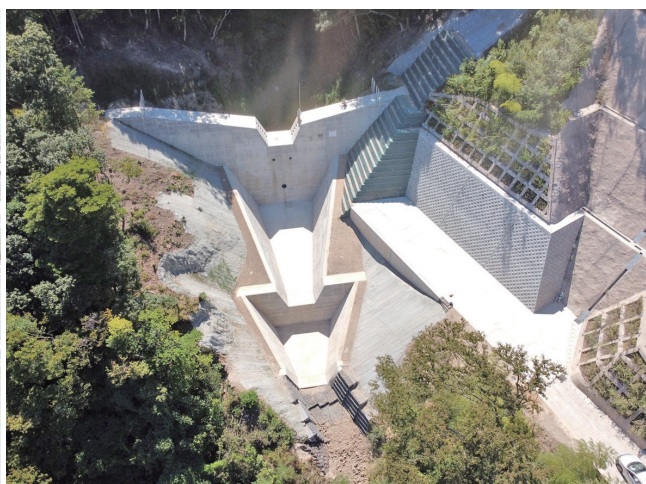
○シシ伏川 砂防えん堤 事業間連携砂防事業 （京丹後市）
