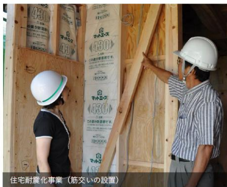
住宅耐震化事業（筋交いの設置）
