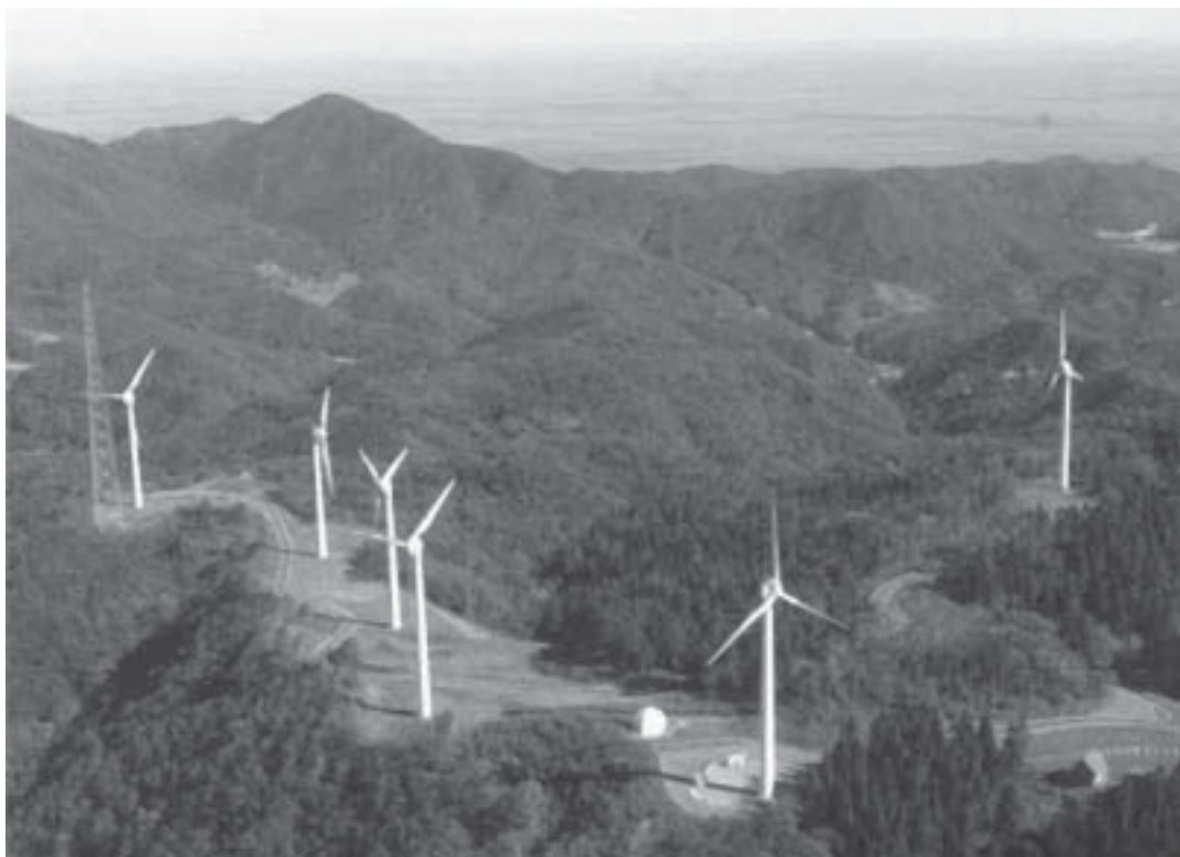
【写真 2.2.2】太鼓山風力発電所全景（京都府企業局提供）
