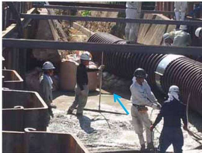
8/25河床コンクリート打設
