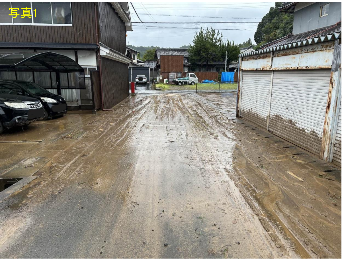
浸水被害状況(令和5年8月台風7号)
