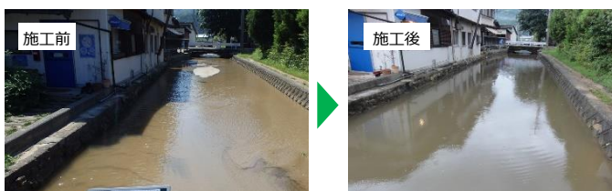
図-1 河道掘削施工イメージ
