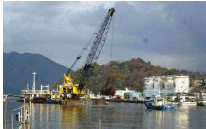
河口部掘削状況
