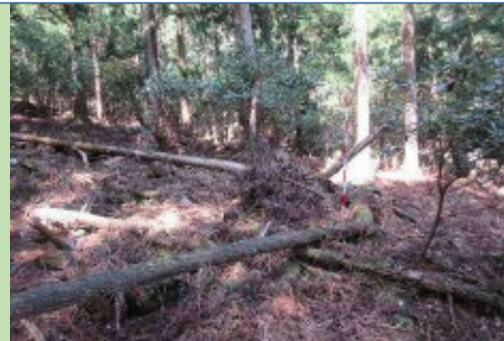
流木の撤去及び固定工（実施前）
