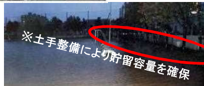
【校庭を活用した貯留施設】
