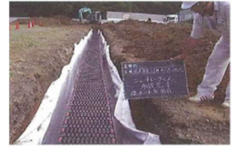
浸透トレンチ
