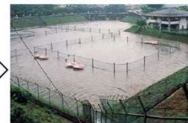
雨水貯留浸透施設の例(防災調整池)
