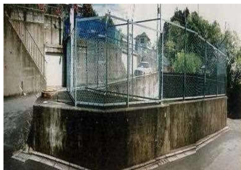
従前の防災調整池
