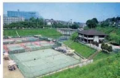
雨水貯留浸透施設の例(防災調整池)
