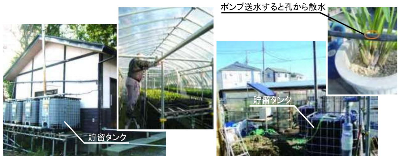
雨水活用施設
