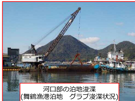
伊佐津川河川整備状況
