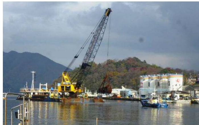
河口部掘削状況
