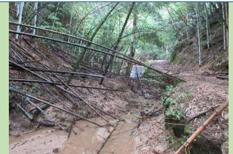
危険木の撤去(実施前)
