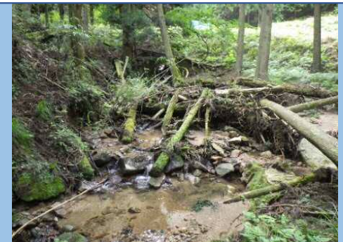
危険木の撤去(実施前)
