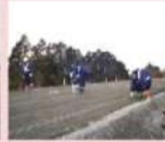
検測と施工を繰り返して整形
