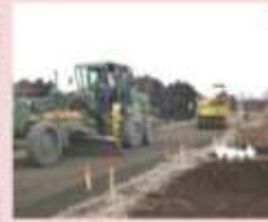
丁張りに合わせて施工
