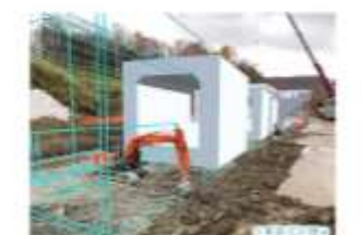
掘削作業時にARと比較
