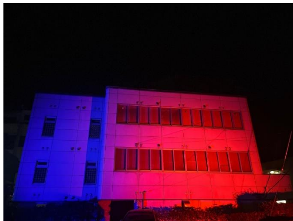
綾部市役所本庁舎北面（綾部市）
