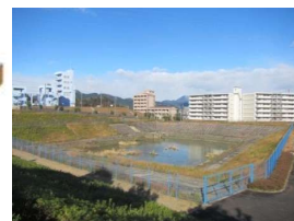
大谷池防災調整池 (平成10年度設置)
