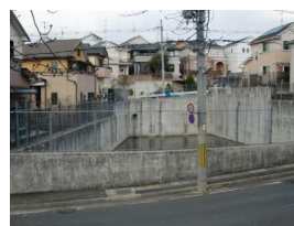
御蔵山調整池 (平成16年設置)
