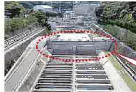
取水路防潮ゲート
