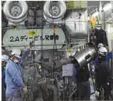
【③使用前検査】 スプレイヘッド 機能性能検査 (使用済燃料ピット漏えい対応)
