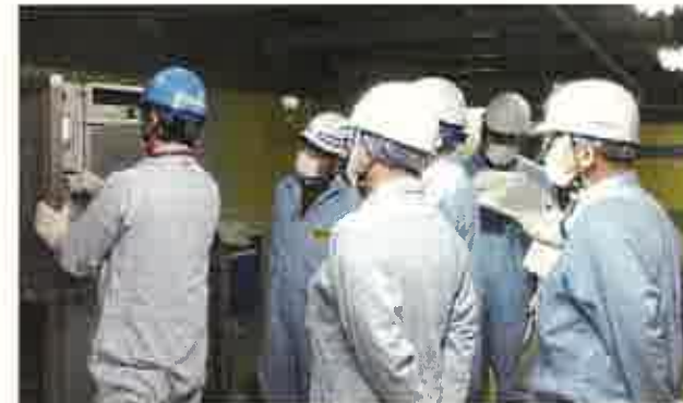
【③使用前検査】 静的触媒式水素再結合装置 機能性能検査
