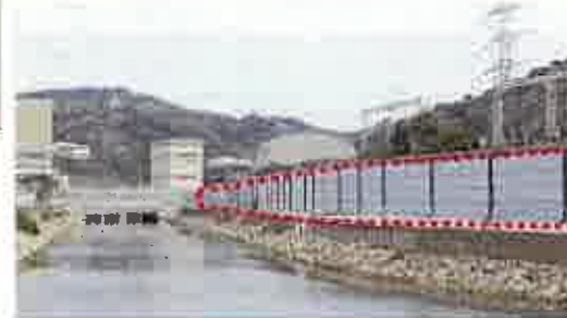
放水口側防潮堤
