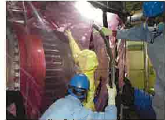
【②再稼動前点検】 余熱除去クーラ開放点検 (水室側ガスケット取替作業)
