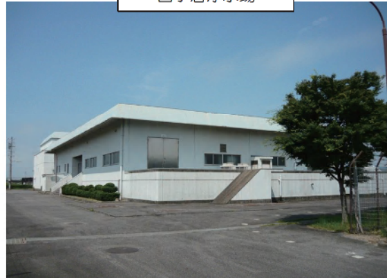
西小倉浄水場
