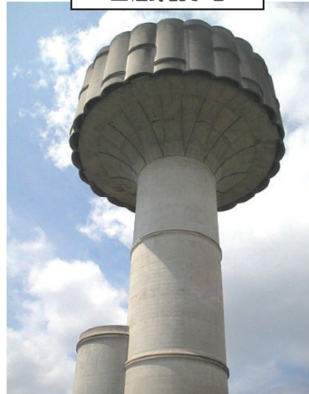
上植野配水塔
