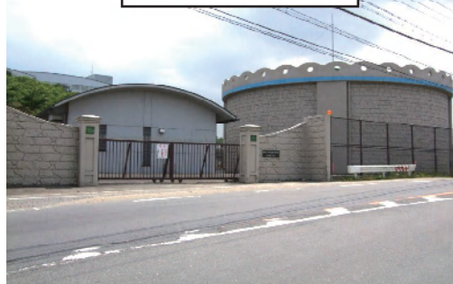
田辺高区配水池
