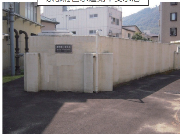
京都府営水道第1 受水池
