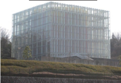
華の塔配水池
