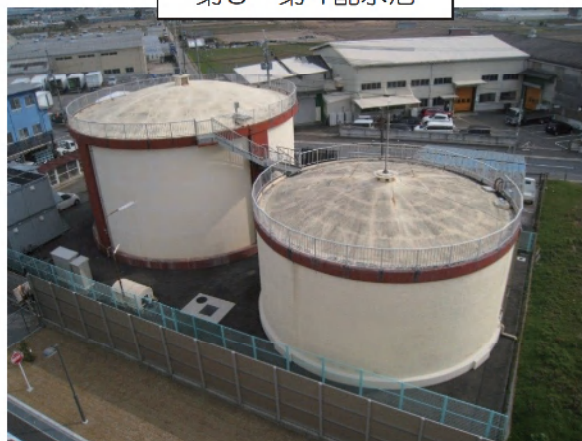
第3・第4配水池
