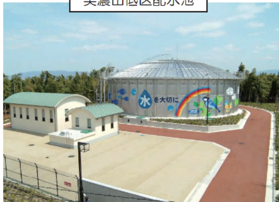
美濃山低区配水池
