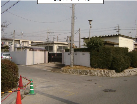
葛原ポンプ場
