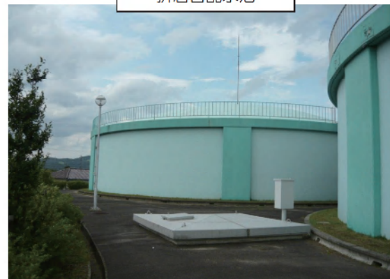
折居台配水池
