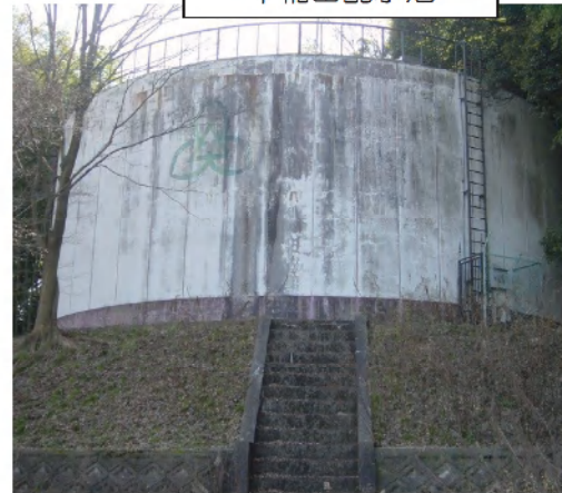
早稲田配水池
