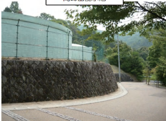
高峰山配水池
