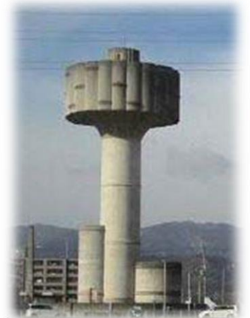
向日市 配水塔
