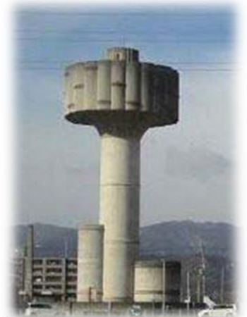
向日市 配水塔
