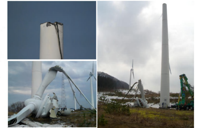
写真1-1 ナセル落下とタワーの破断状況
