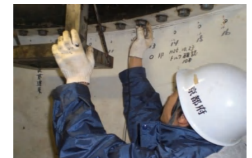
写真2 タワートップボルト超音波探傷試験
