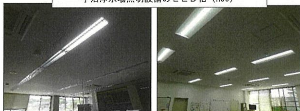
宇治浄水場照明設備のLED化(H30)
