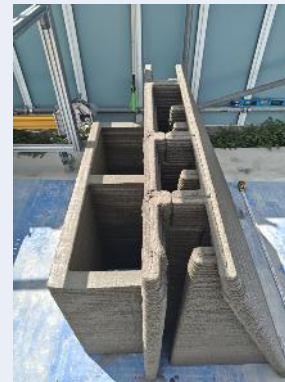
◀3Dプリンタにより 完成した製品 （所定位置に設置し、 コンクリートを充填）
