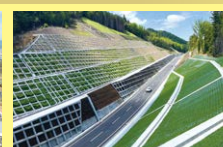
国道423号 法貴バイパス(亀岡市)
