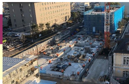
(工事の状況(令和4年1月現在))
