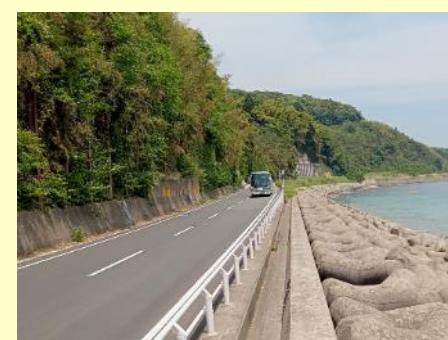
国道178号 (里波見～長江(宮津市))
