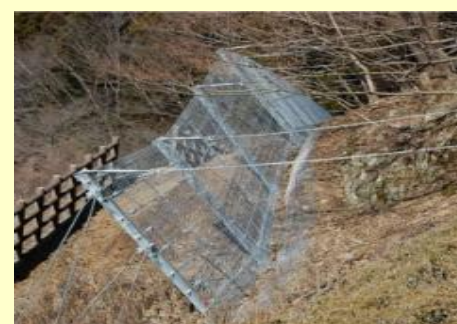
亀島地区 (落石対策) 【伊根町】
